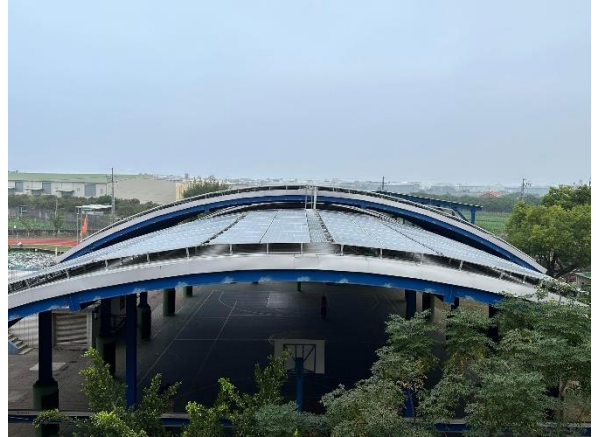
學校風雨球場屋頂上增設太陽能發電設施
